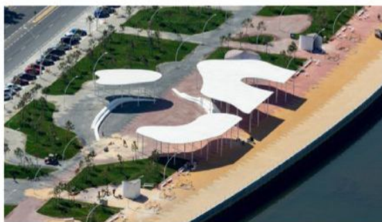
Paseo de la Ría [COS0223] Huelva Martínez Lapeña - Torres Arquitectos
